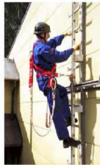
شکل ۱۱ - سامانه متوقف کننده با استفاده از ریل مخصوص در نردبان
