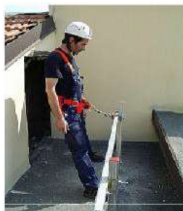
شکل ۴- ۵۴ محدودکننده با اتصال یک ریل مخصوص
