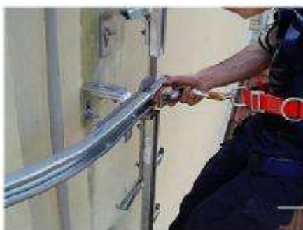
اشکال ۱۱۱- سامانه محدود کننده با استفاده از رول
