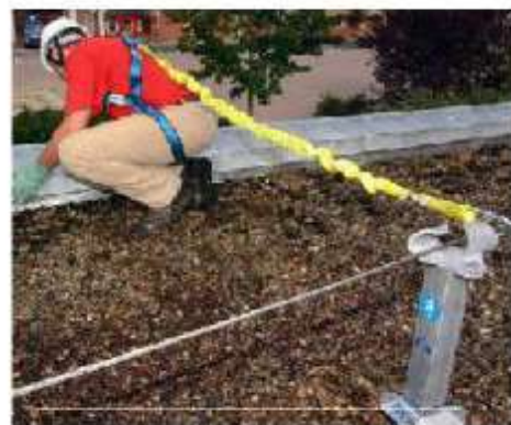
شکل ۵۴-۲ محدود کننده با اتصال یک طناب
