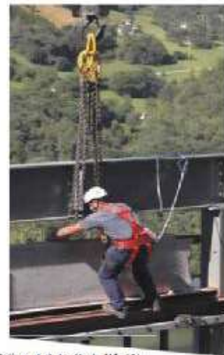
شکل ۷۵- استفاده از ابزار متوقف کننده در اجرای سازه فلزی
