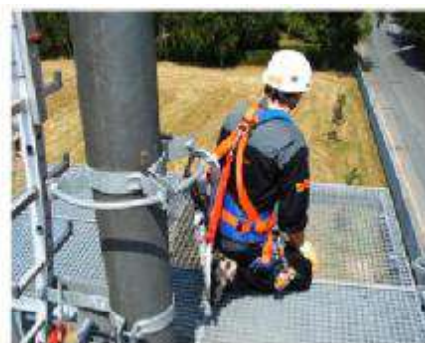
اشکال ۱۱۱- سامانه محدود کننده با استفاده از رول
