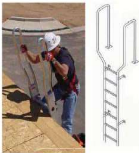
شکل ۶-۱ دستگیره نردبان ثابت
