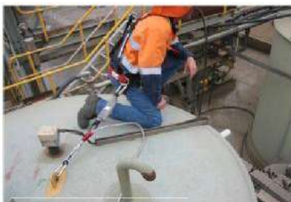
شکل ۳- ۵۴ محدودکننده با اتصال یک نقطه
