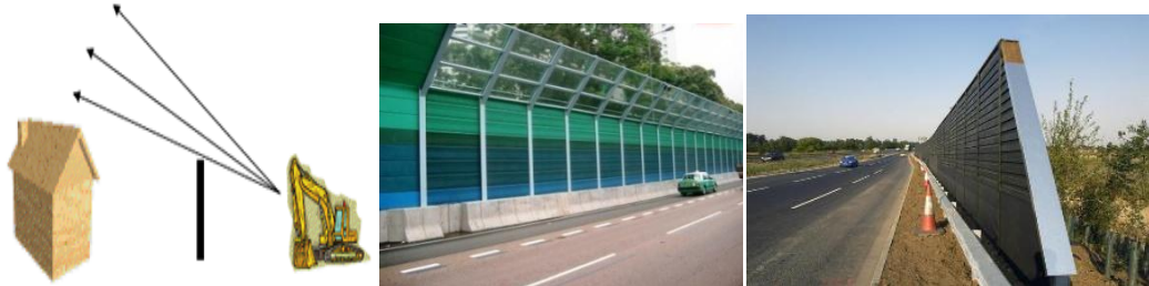
شکل شماره ۷- ایزوله کردن منابع مولد صدا با نصب مانع (در صنعت و محیط زیست شهری)
